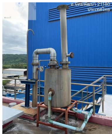
ภาพที่ 2.2-2 ระบบ Scrubber บริเวณปล่องหน่วยล้างเตรียมสารเร่งปฏิกิริยา
