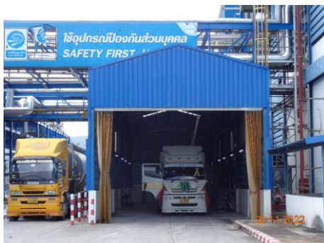
ภาพที่ 2.2-1 ระบบควบคุมฝุ่นระหว่างการขนถ่าย PTA จากรถบรรทุก
