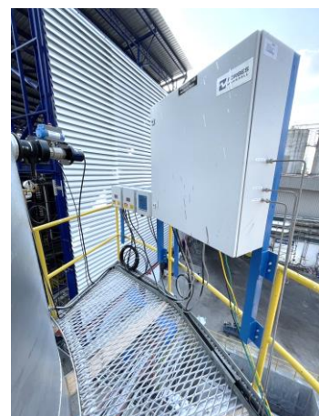
ภาพที่ 2.2-56 การติดตั้งอุปกรณ์ตรวจวัดมลสารทางอากาศแบบต่อเนื่อง (CEMs)
